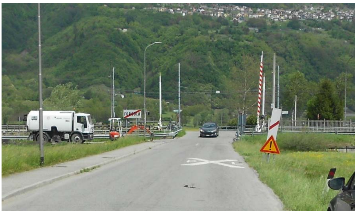
Figura 2.1 – Passaggio a livello al km 24+270 da sopprimere
